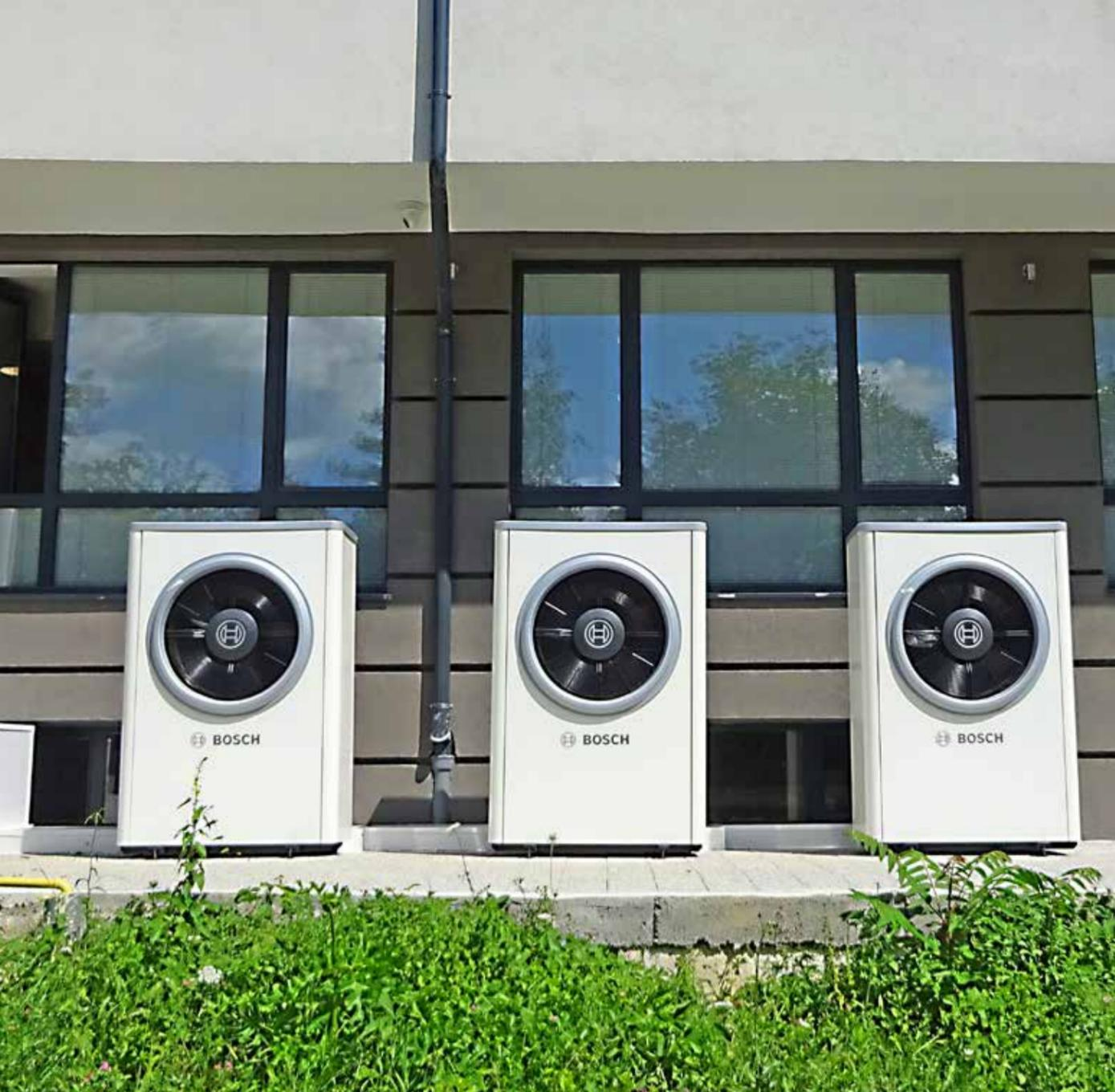
*Compress 6000 AW: COP (A7W35 стандарт EN14511) до 5,1 и SCOP до 4,84. Работен диапазон при външна температура от -20 до +46 °C. Инверторна технология. Максимална температура на подаваната вода за отопление до 62 °C.*
