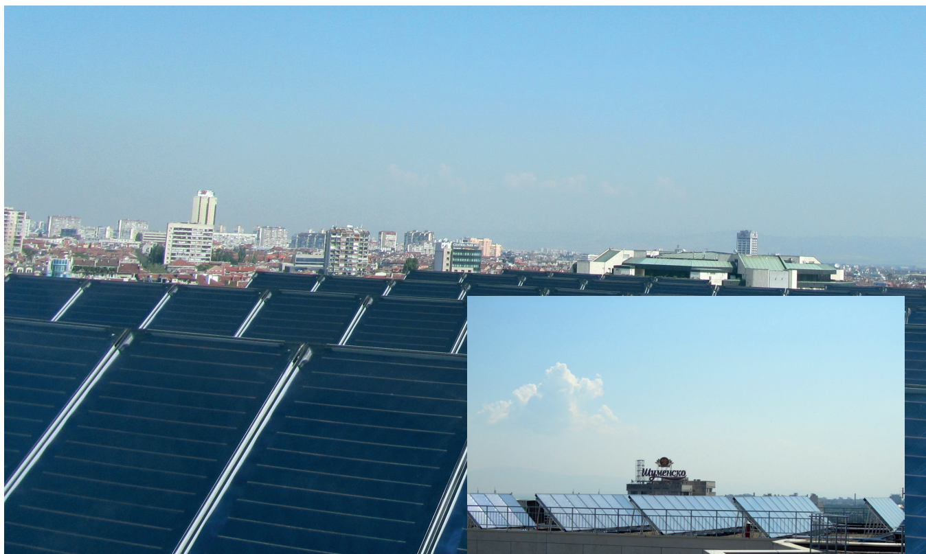
45 соларни колектора Bosch Solar 7000TF
