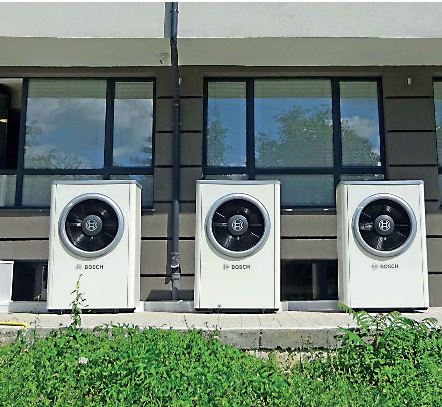
Compress 6000 AW: COP (A7W35 стандарт EN14511) до 5,1 и SCOP до 4,84. Работен диапазон при външна температура от -20 до +46 °C. Инверторна технология. Максимална температура на подаваната вода за отопление до 62 °C.
