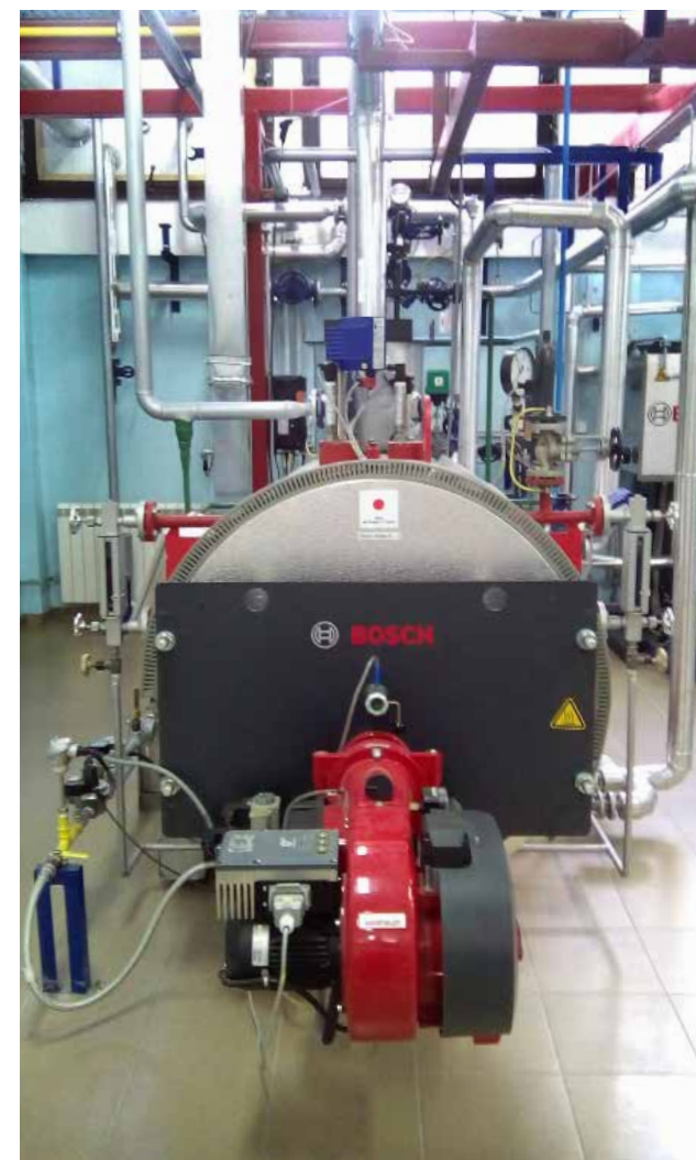
Парен котел UH-D с економайзер от страната на отработените газове
