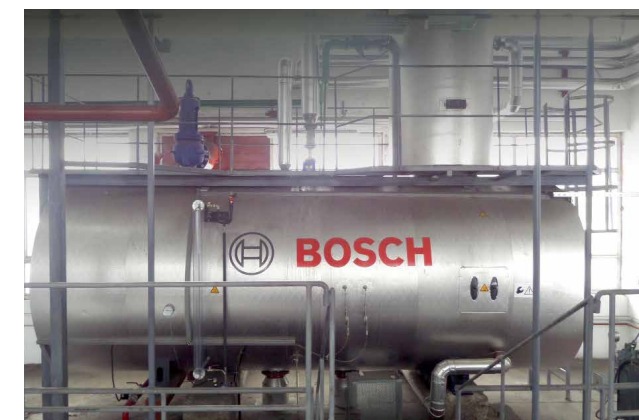
Модул за подаване на вода с пълно обезгазяване WSM-V
