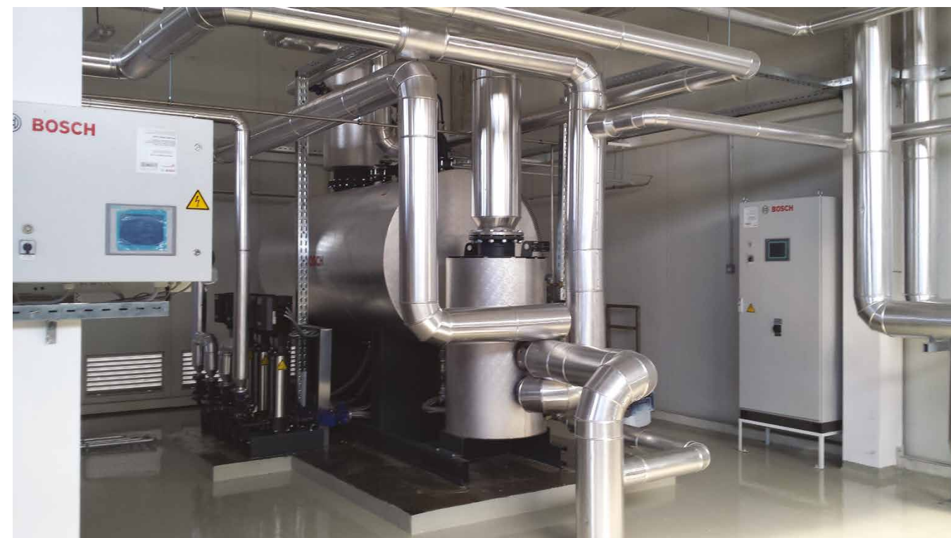
U-MB (Универсален модулен котел) - триходов парен котел със стоманен корпус
