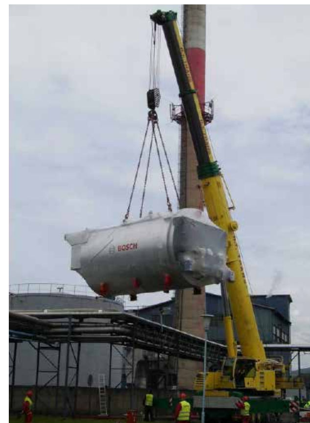
Парен котел ZFR с предварително сглобени горелки, готови за бърз монтаж
