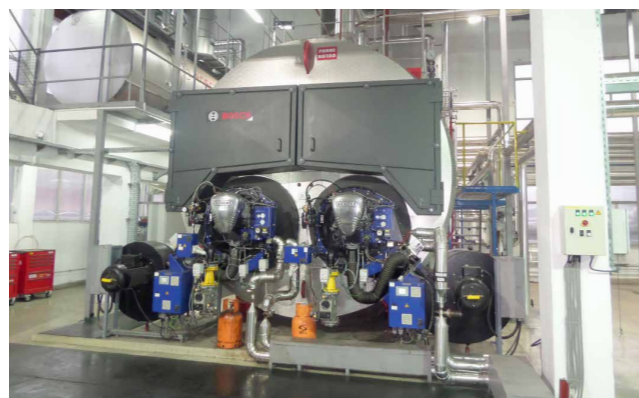
Парен котел с двоен пламък ZFR 28000, за тежко котелно гориво и газ
