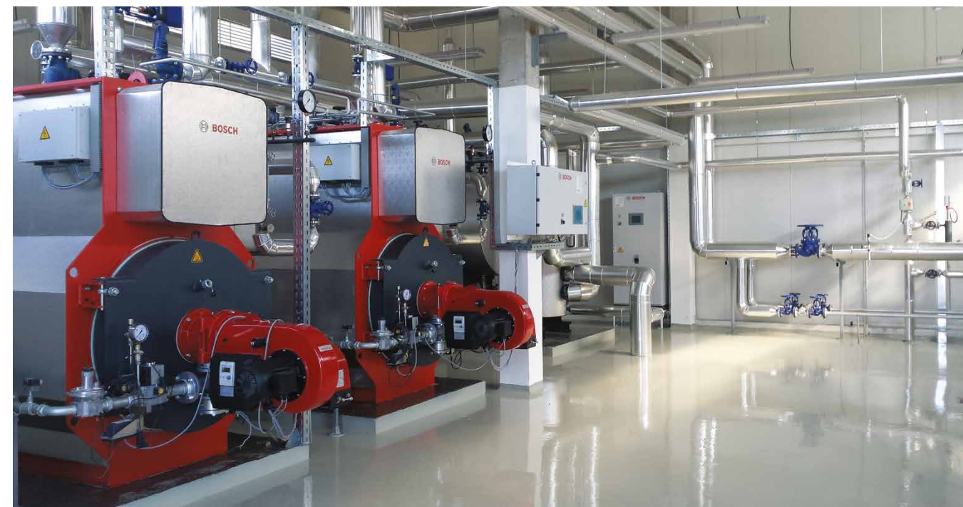
U-MB (Универсален модулен котел) - триходов парен котел със стоманен корпус
