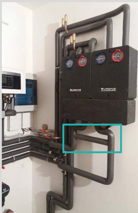
Správné dimenzování bypassu dle pokynů.
