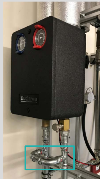
Správné dimenzování bypassu, tvar „U“.
