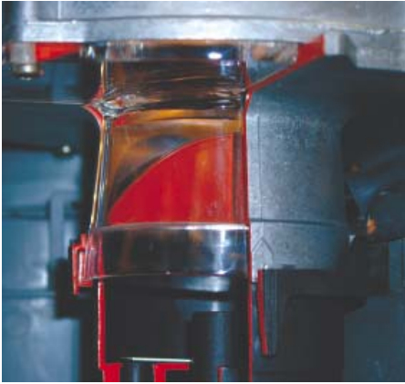
Obrázek 3: Kondenzační kotel v provozu s otevřenou „klapkou“ - pojistkou zpětného proudění
