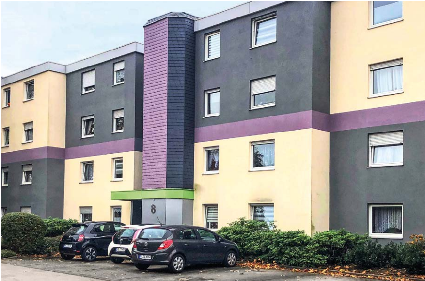
Bau-AG, Kaiserslautern Gebäudestruktur: gemauert mit Kalksandstein, nicht isoliert, Fenster und Dacherneuerung/Flachdach werden in 2023/24 durchgeführt Vorher: Gas-Kombithermen ZWR18/24 KE/AE Nachher: 28 Wohnungsstationen Flow 8001/35, kombiniert mit Fernwärme
