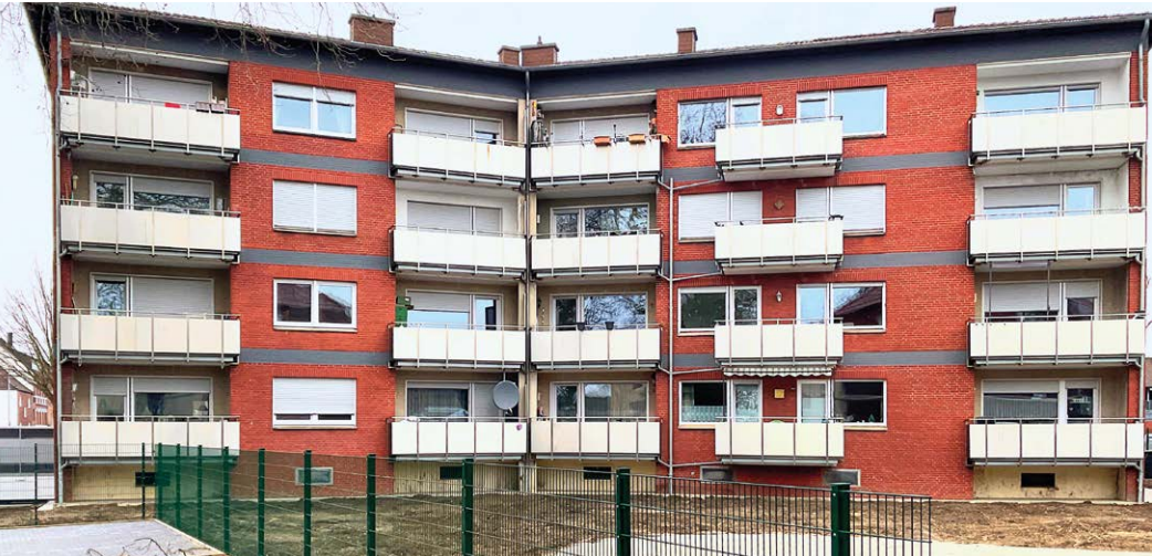
WSG Coesfeld, Dülmen Durchgeführte Maßnahmen: Grundrissoptimierung, neue barrierearme Bäder, Fenster mit 3fach-Verglasung, Wärmedämmung Dach und Kellergeschoss, Wohnumfelderneuerung, neue Zimmer-/Wohnungs- und Haustüren Vorher: zentraler Gaskessel Nachher: Gas-Brennwertgerät mit Luft-Wasser-Wärmepumpe (38 kW) und Frischwasserstation als zentrale Austauschlösung
