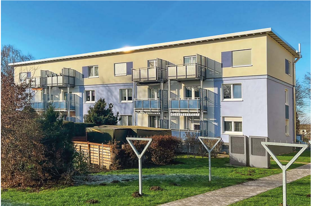
Dogewo 19 Gebäude mit 180 Wohneinheiten. Vorher: Gas-Kombithermen ZWR18 KE Nachher: Hybrid-Gas-Brennwertgerät mit Luft-Wasser-Wärmepumpe (22 kW) und Wohnungsstationen Flow 8001 als zentrale Austauschlösung
