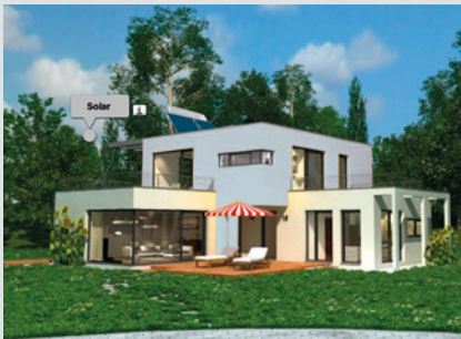
Termosifón sobre cubierta
