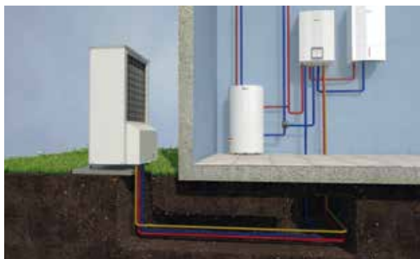
Compress s AWB(S), bivalentan način rada
