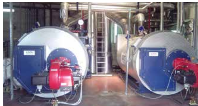
Parni kotlovi sa modulom napojne vode WSM-V
