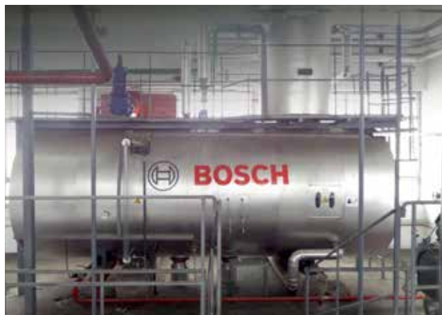
Napojni spremnik s potpunim otplinjavanjem WSM-V
