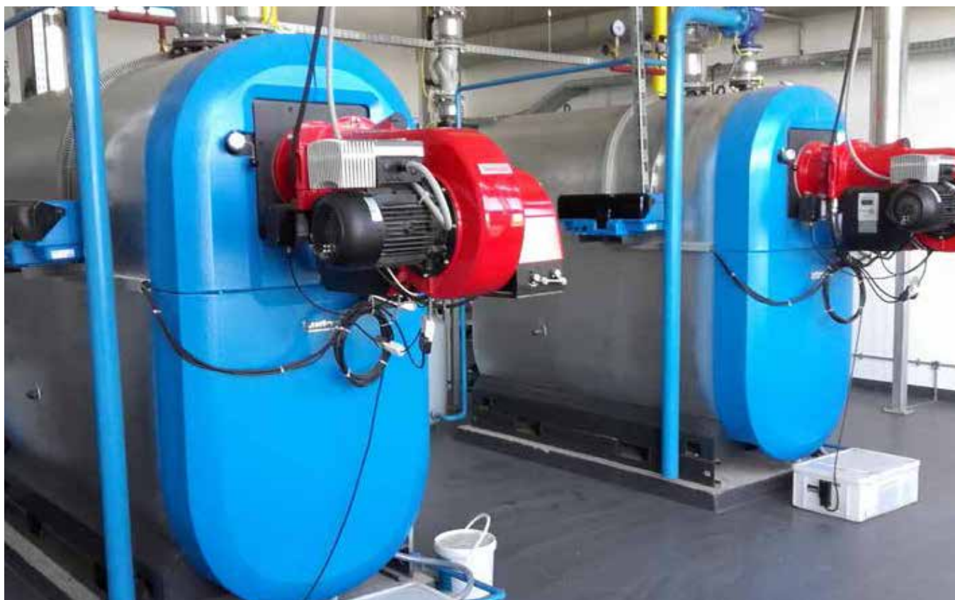
Kondenzacijski kotlovi Logano plus SB 745
