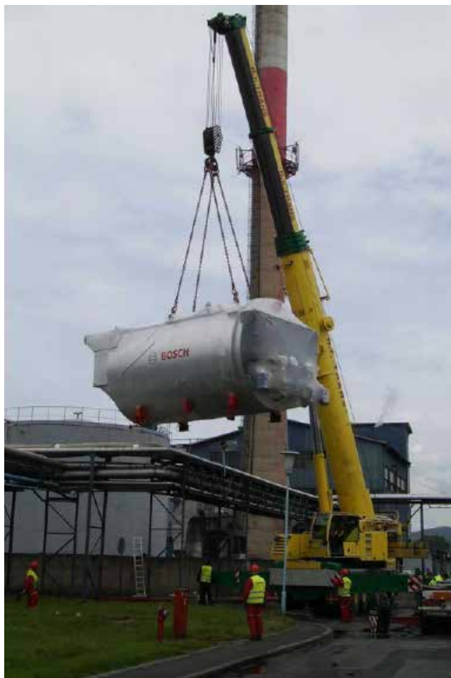
Parni kotao ZFR s predmontiranim plamenicima, spreman za brzo instaliranje
