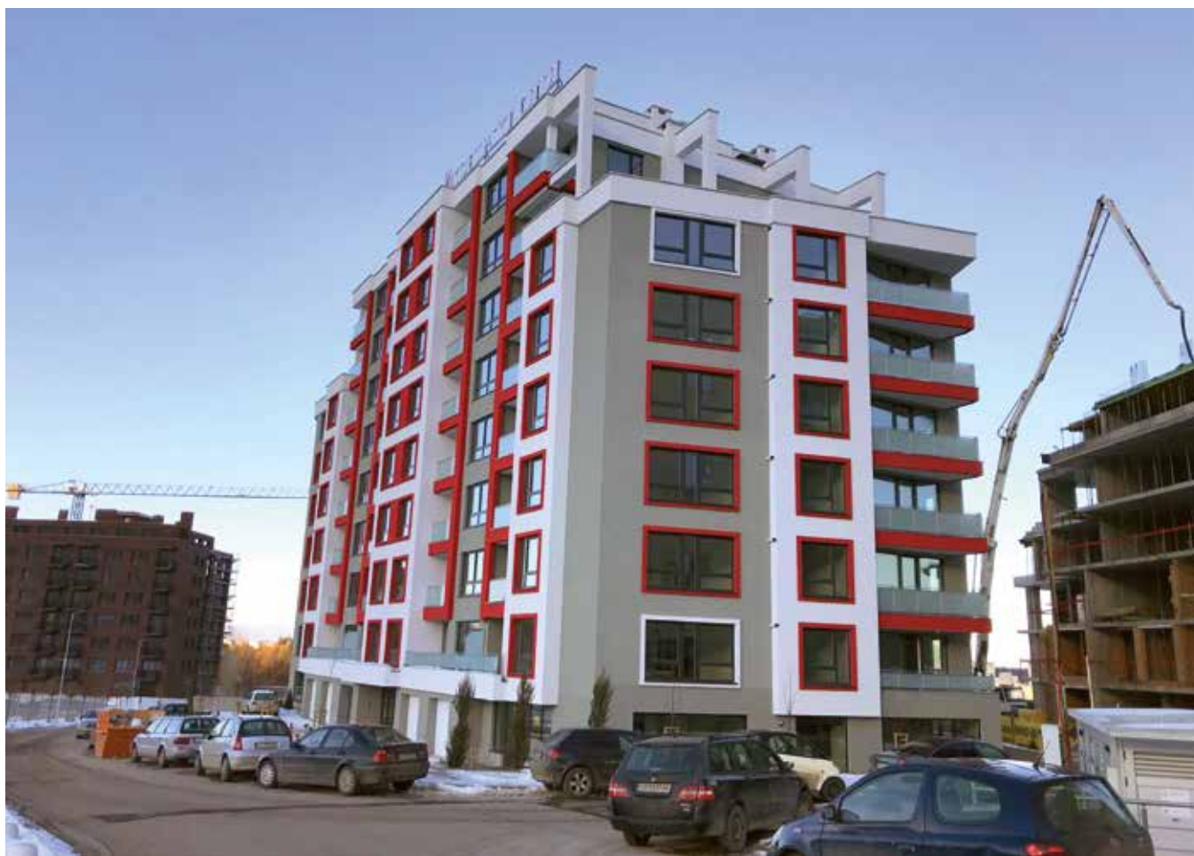
70 Condens 2500 W kondenzacijskih kombiniranih plinskih kotlova s koaksijalnim dimovodnim elementima,
