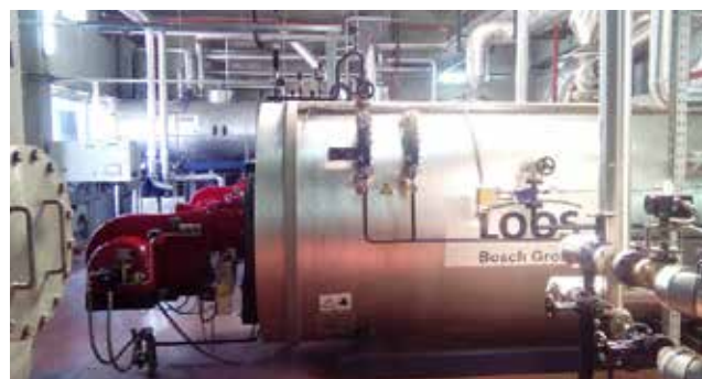
Kotlovnica s regulacijskim ormarom sustava SCO
