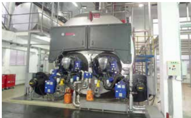
Parni kotao s dvostrukom plamenom cijevi ZFR 28000, s loženjem na teško loživo ulje i prirodni plin
