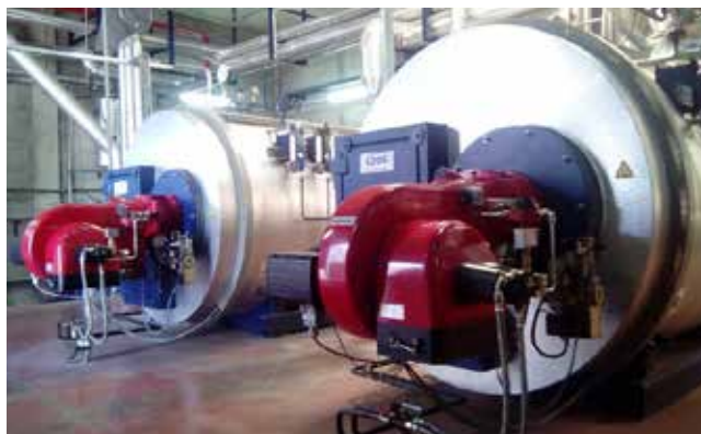
UL-S 3200 parni kotlovi, 6 t/h ukupnog kapaciteta, gorivo lako loživo ulje / prirodni plin
