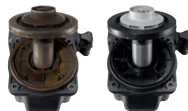
Osady magnetytu i szlamu na pompie cyrkulacyjnej instalacji grzewczej
