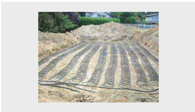
Fig. 73 “Slinky” loop
